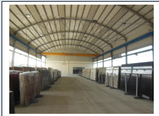
capannone Savema spa Pietrasanta, con Geom. Nari
