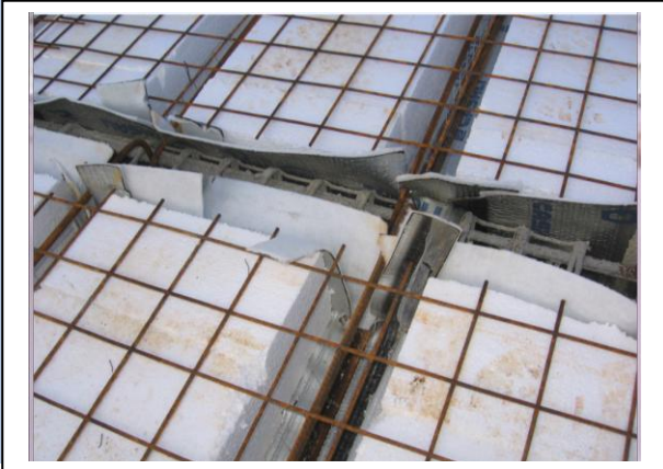
solaio prima del getto finale
